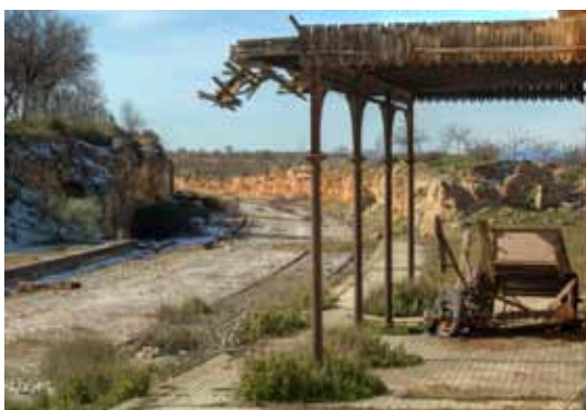
Vías desmanteladas en la línea Guadix-Almendricos
