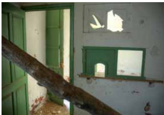
Interior abandonado de oficinas y taquillas de una de las estaciones del recorrido
